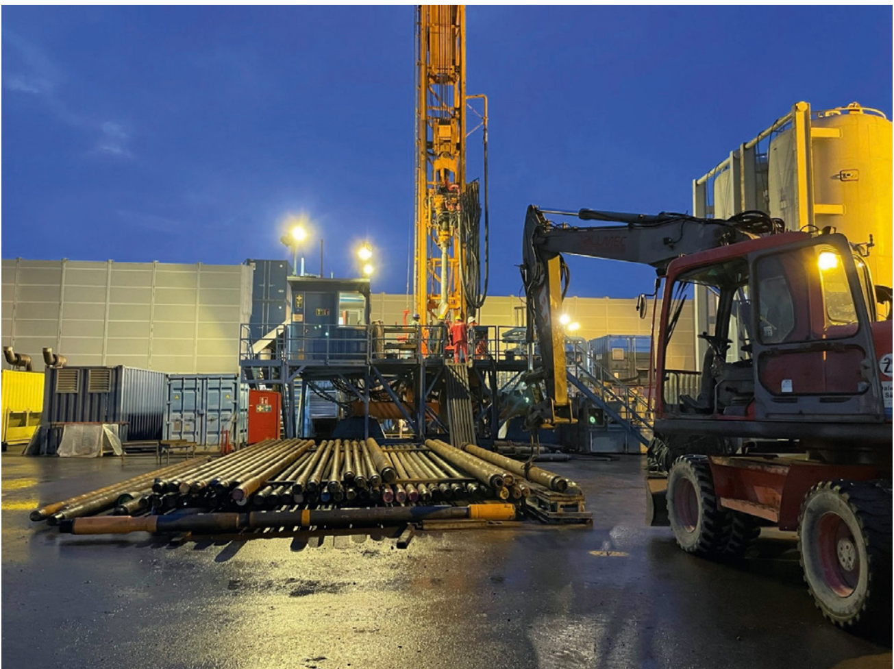
Abb. 3 Bohranlage der Firma Daldrup & Söhne mit Gestängelager
